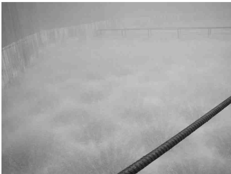
Рис. 3. Фотография работы системы водораспределения с соплами
