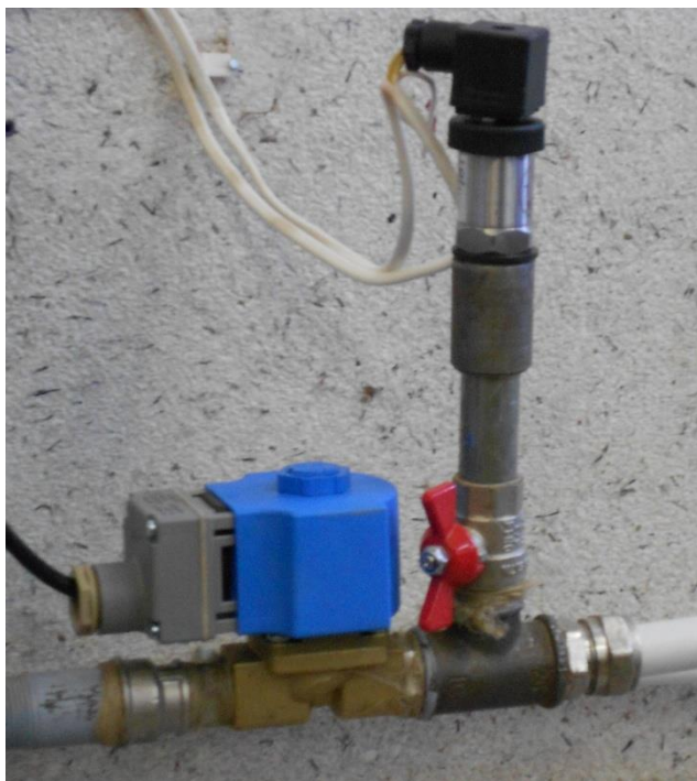
Рисунок 2.25 – Регулирующий клапан EV 260B
