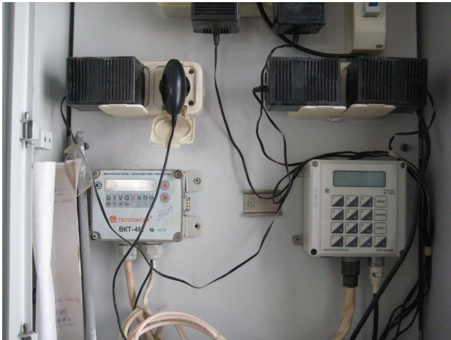
Рисунок 1.6 – Тепловычислители узла учёта типа ВКТ-4 и СТД
