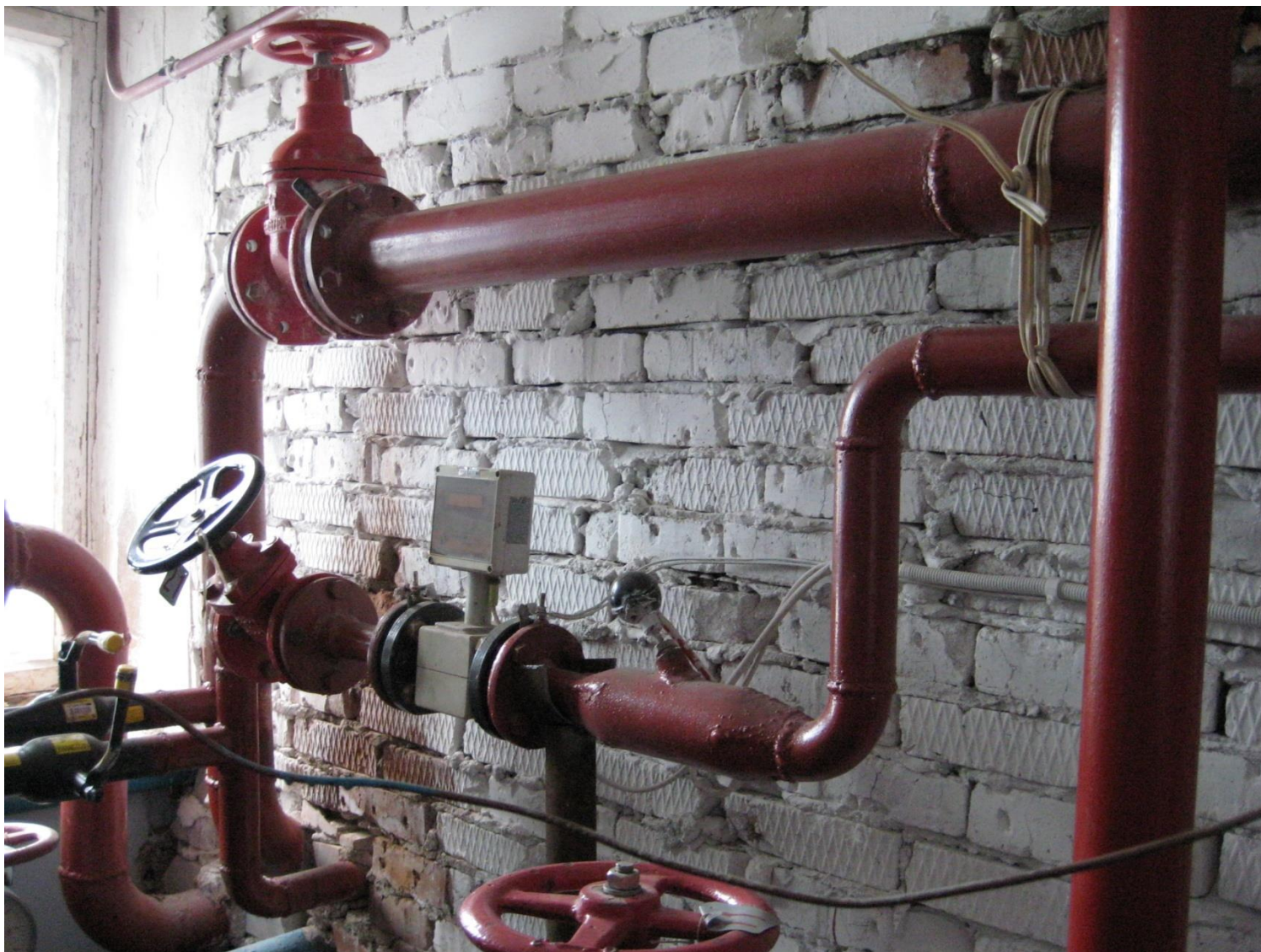
Рисунок 1.9 – Преобразователь расхода электромагнитный
