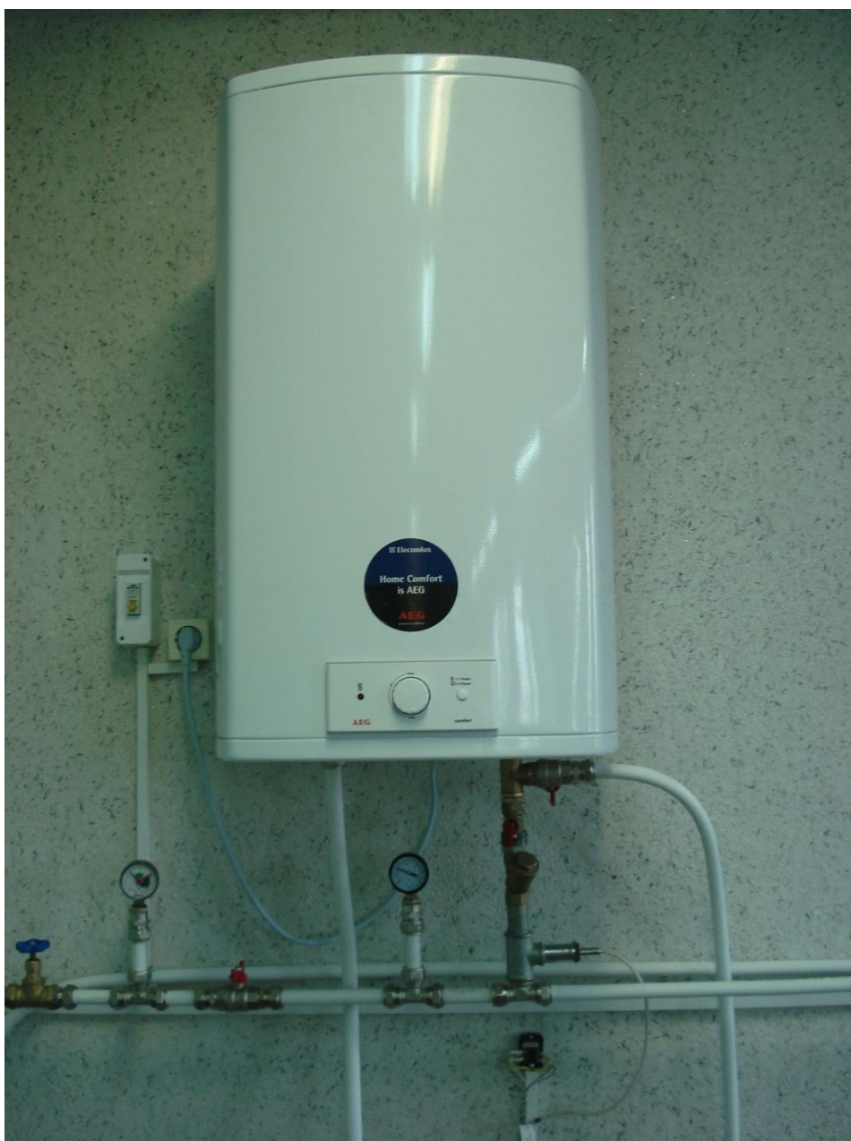
Рисунок 1.21 - Водоподогреватель ёмкостного типа
