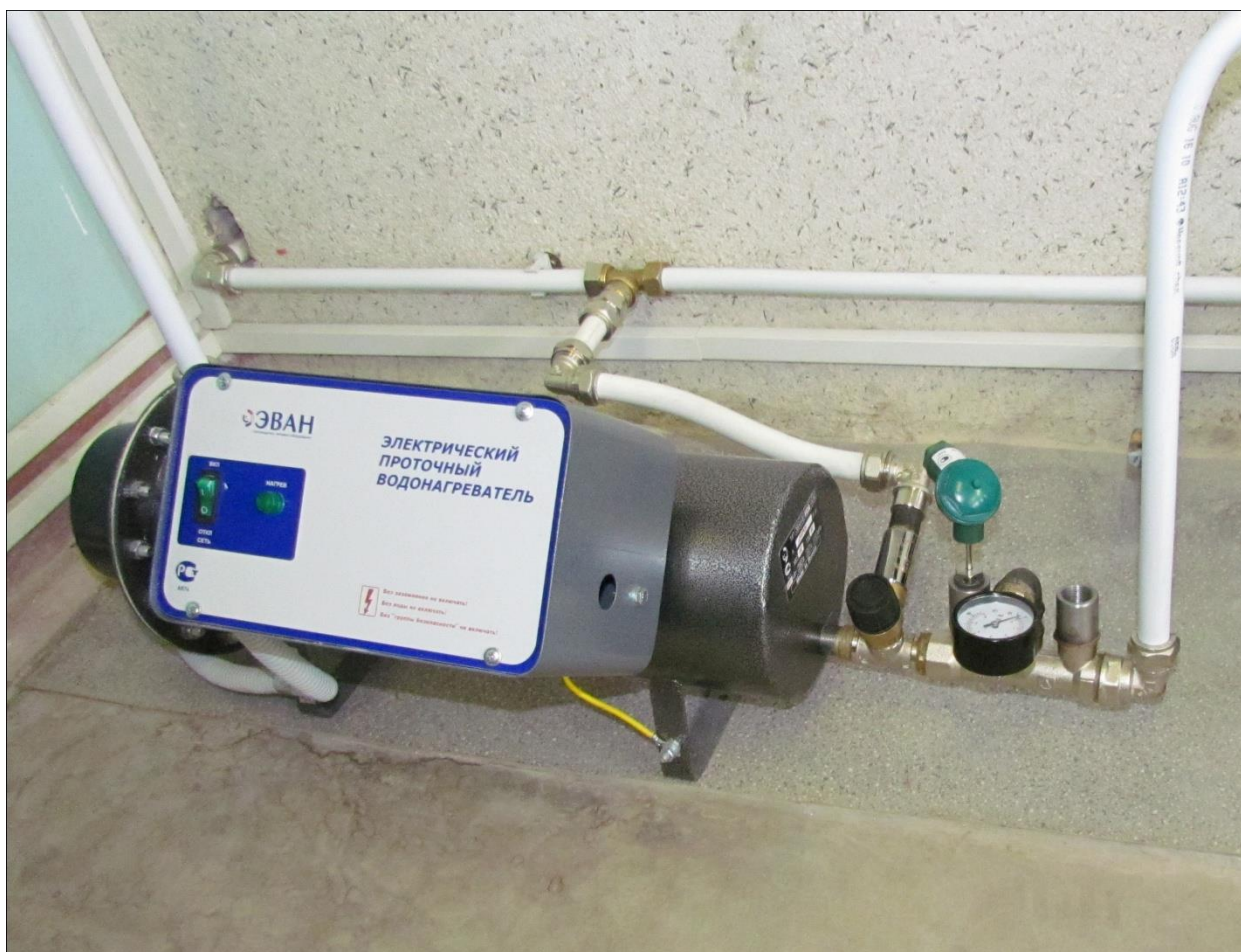
Рисунок 1.27 - Электрический проточный водонагреватель
