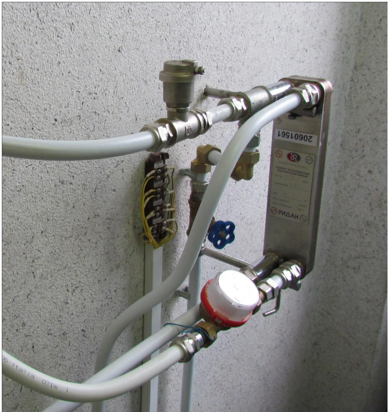
Рисунок 1.20 - Пластинчатый теплообменник
