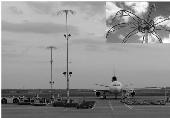
Рис. 1. Применение «активных» DAS-молниеотводов в аэропорту (США)
