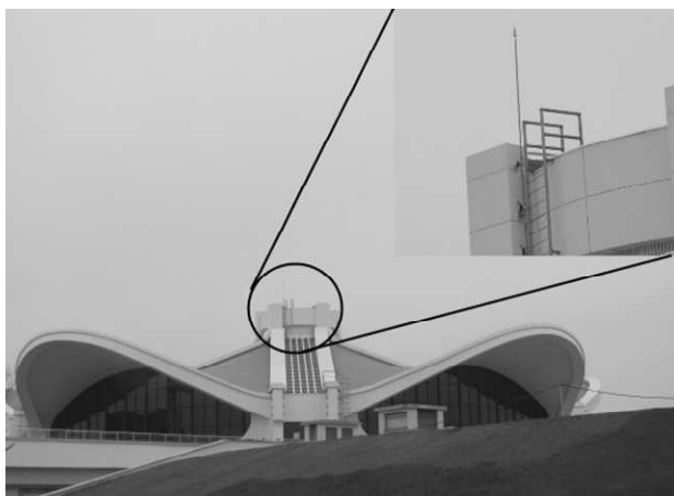
Рис. 1. Применение ESE-молниеприемника.
