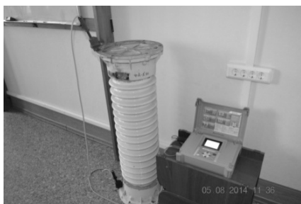
Рис. 1. Измерение сопротивления РВ с помощью прибора Metrel
