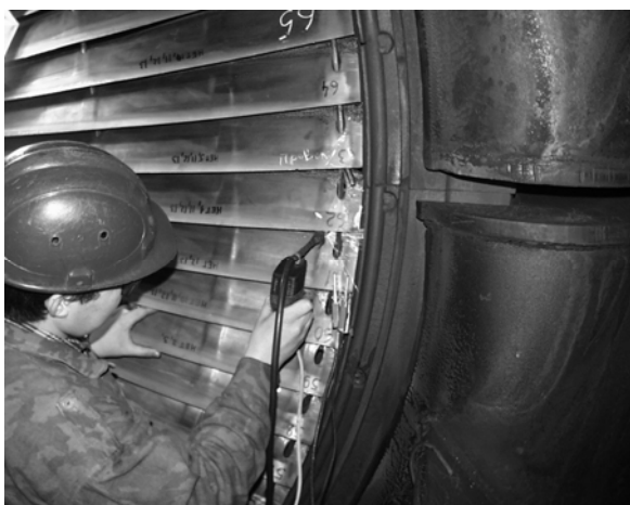
Рис. 5. Нанесение металллизатором защитных покрытий на лопатки 29-й ступени через конденсатор при ремонте турбины К-300-240 ЛМЗ ОАО «Рязанская ГРЭС» (ст. №3)
