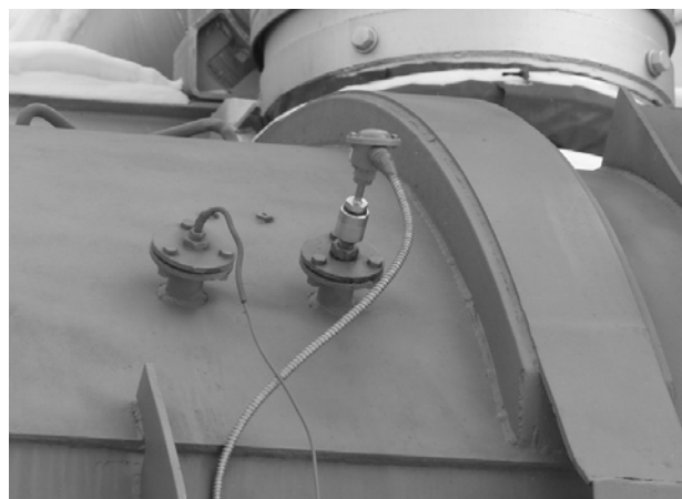
Рис. 4. Датчик температуры верхних слоев масла
