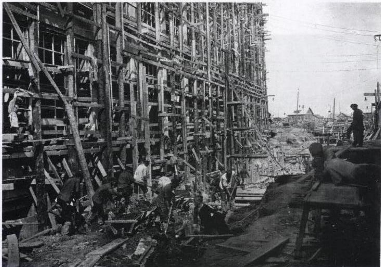
Строительство главного корпуса ИвГРЭС
